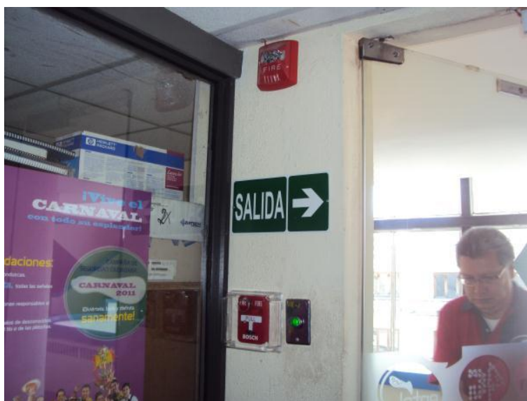
Sirena y activador del Sistema de Alarma. Edificio Ayacucho
