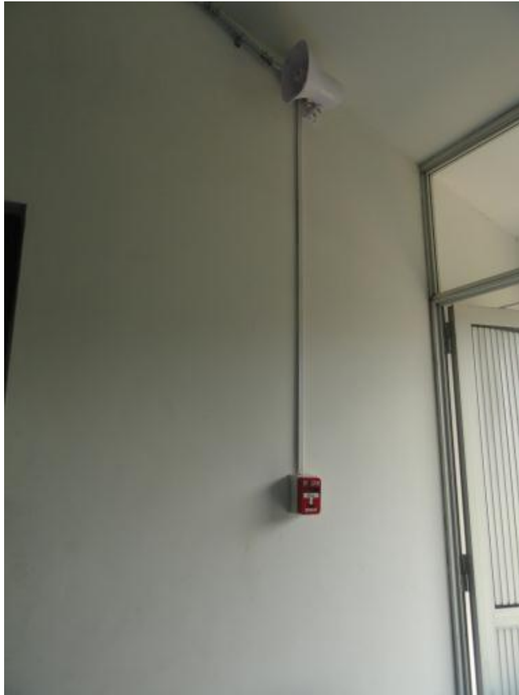
Activador y Sirena en Edificio Warnes
