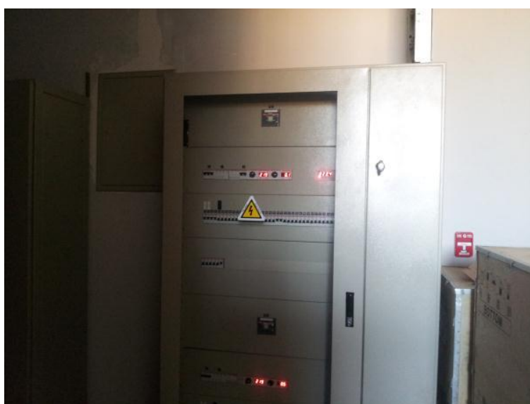
Panel eléctrico con protección de térmicos secundarios. Cbba.
