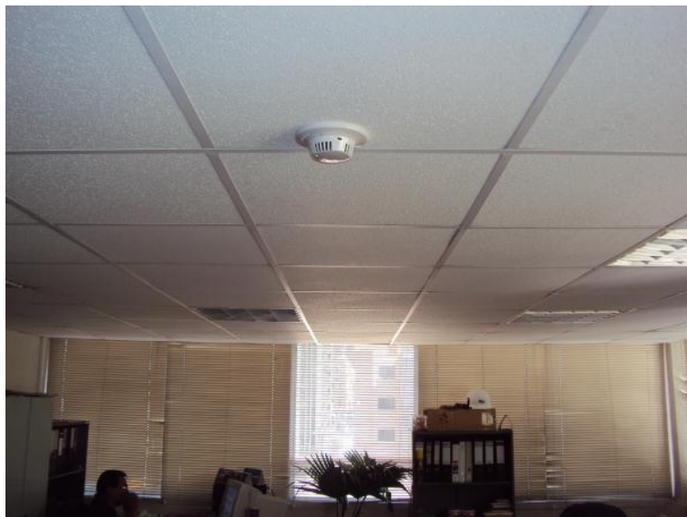
Sensor de humos en Edificio Ayacucho
