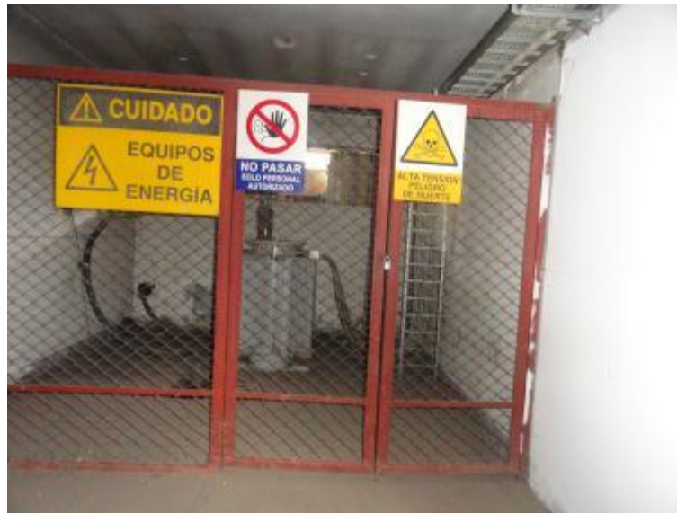
Protección y advertencia de riesgo eléctrico. Transformador en Santa Cruz
