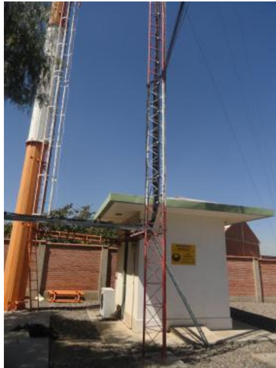
Escaleras protegidas en antena. Santa Cruz
