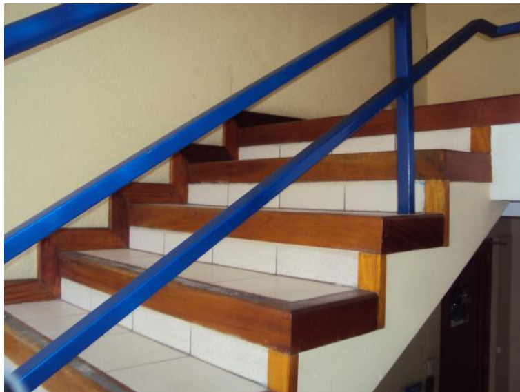
Gradas con barandas y huellas antideslizantes en Edificio Tower
